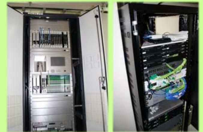
無線回線制御装置 (左) 指令制御装置 (右)
